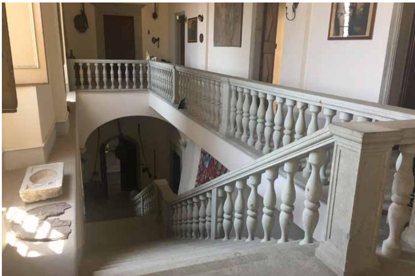
Un monumental escalier en pierre dessert les étages du palais qui est ouvert partiellement aux visiteurs lorsque les beaux jours reviennent.
